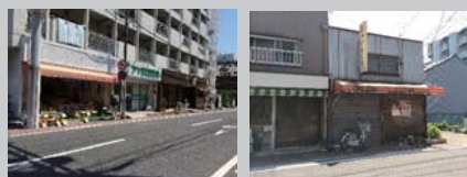
[写真] 新大門商店街(中村区)
