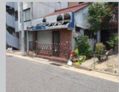
【写真2】店のテント・看板などが破損している
