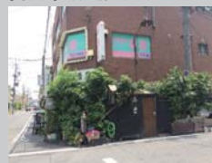
【写真5】店の前に手入れのされていない植木が沢山ある
