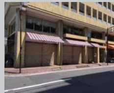
【写真1】シャッターが下りている
